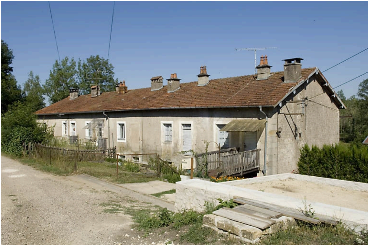
Logement ouvrier collectif (impasse Albert Ricot).
