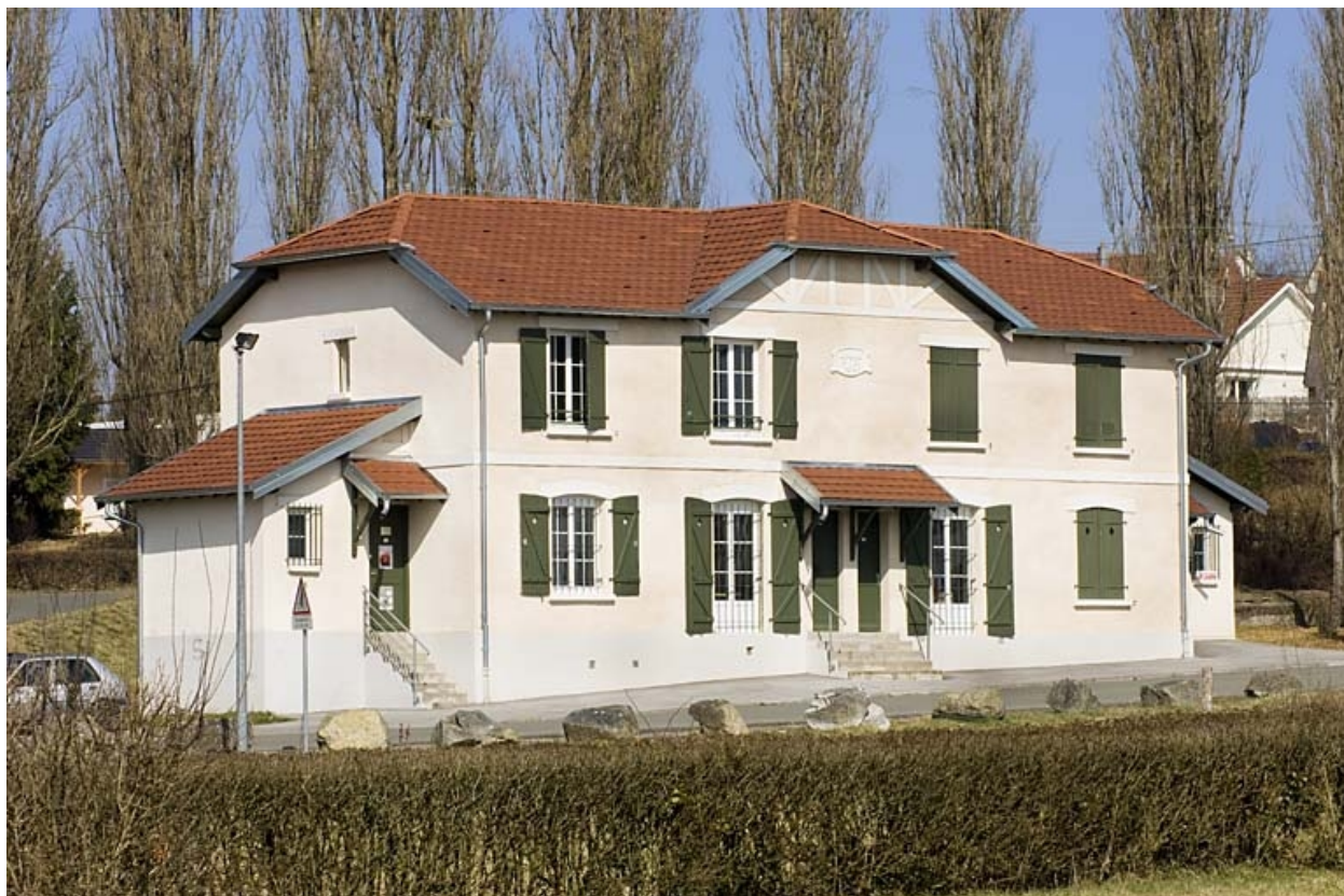
Habitation à 4 logements vue depuis le sud-ouest.
