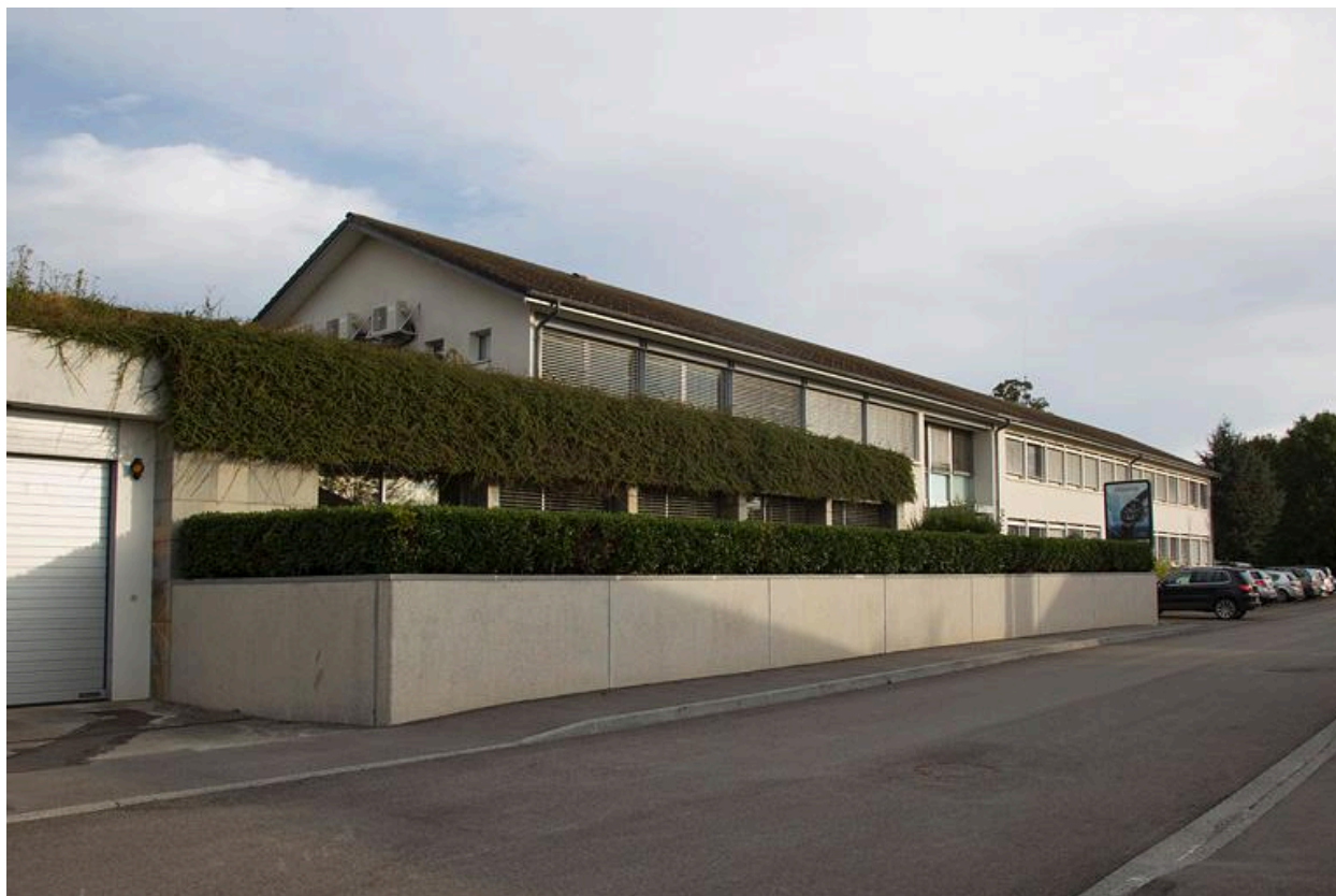
Usine de montres Herbelin, à Charquemont.
