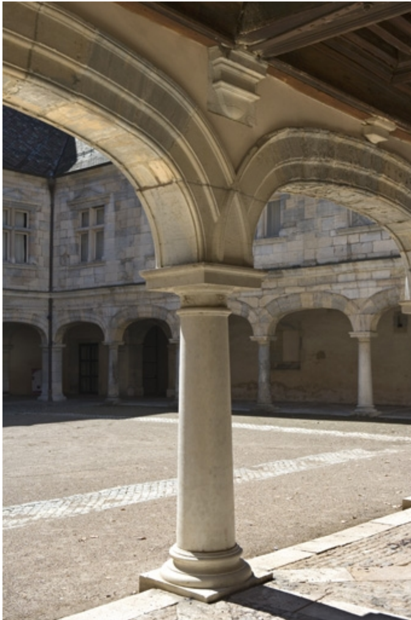
Détail du portique sud-ouest depuis le nord-ouest.
