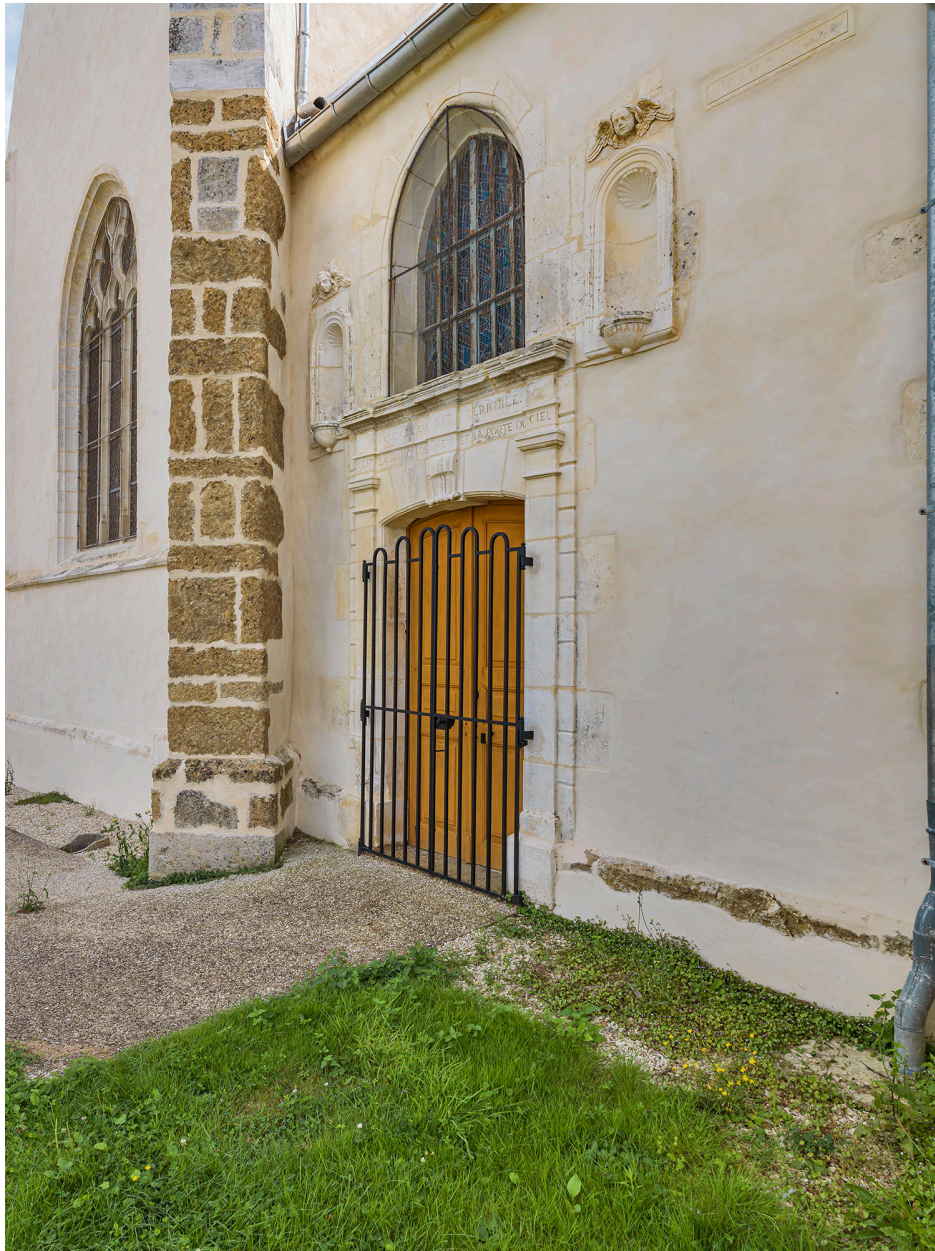
Portail d'entrée nord.
