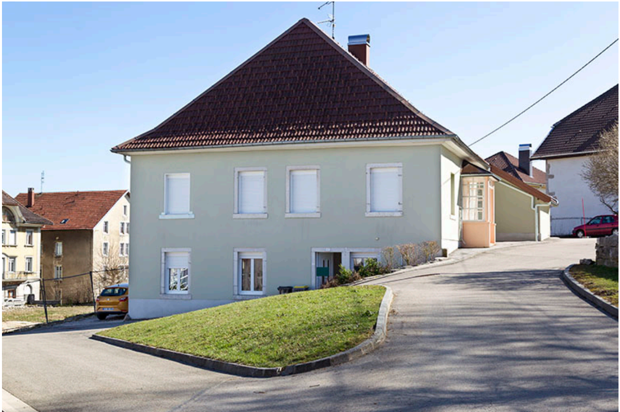
Façade latérale gauche, de trois quarts droite.
