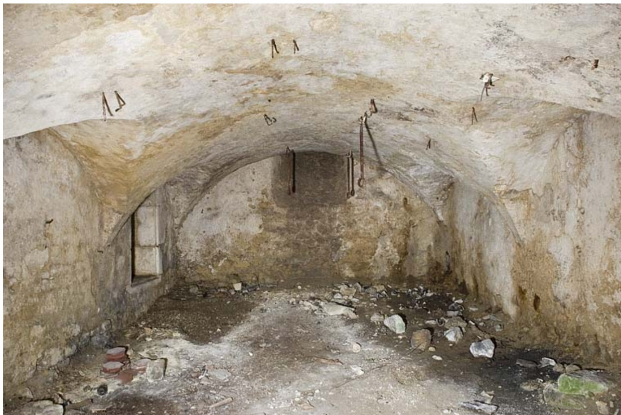
Vue générale du sous-sol.
