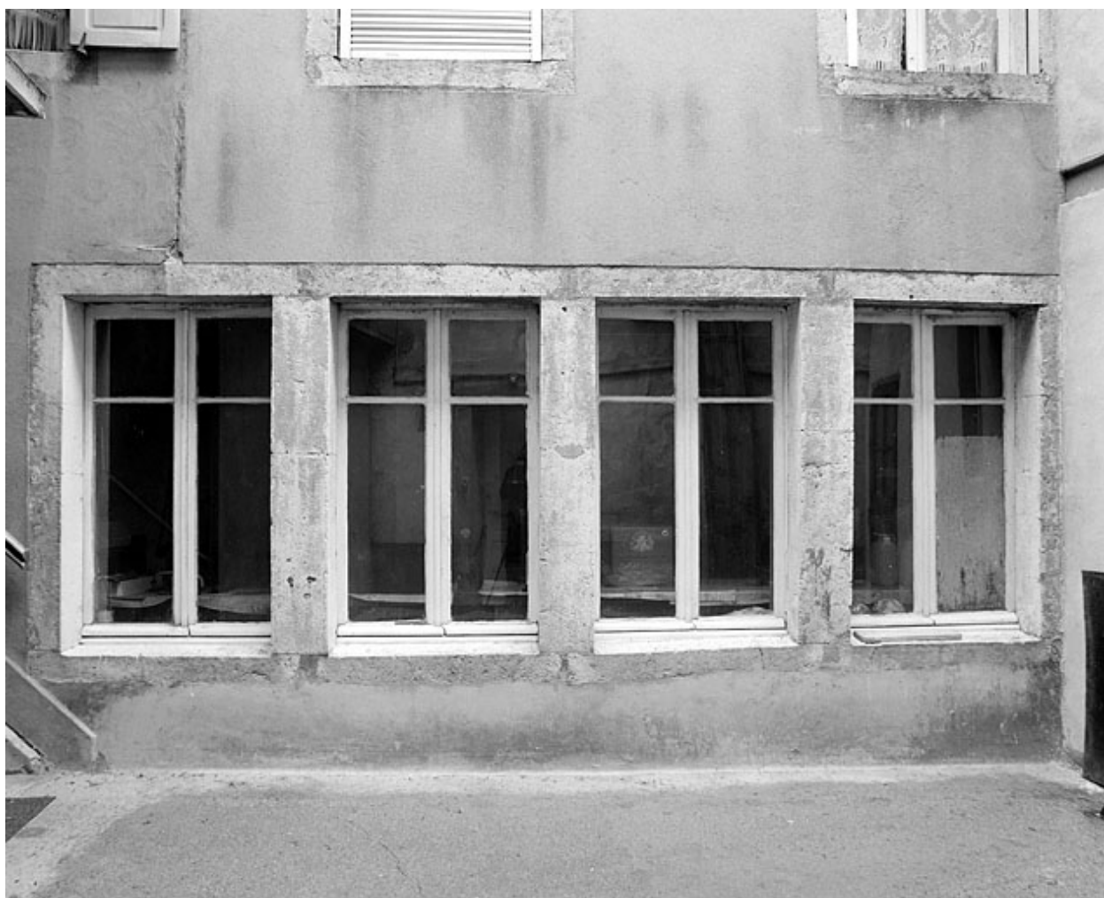
Aile sud : fenêtres jumelées.
