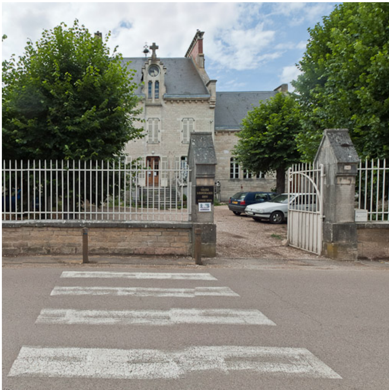
Vue du pensionnat depuis la route.
