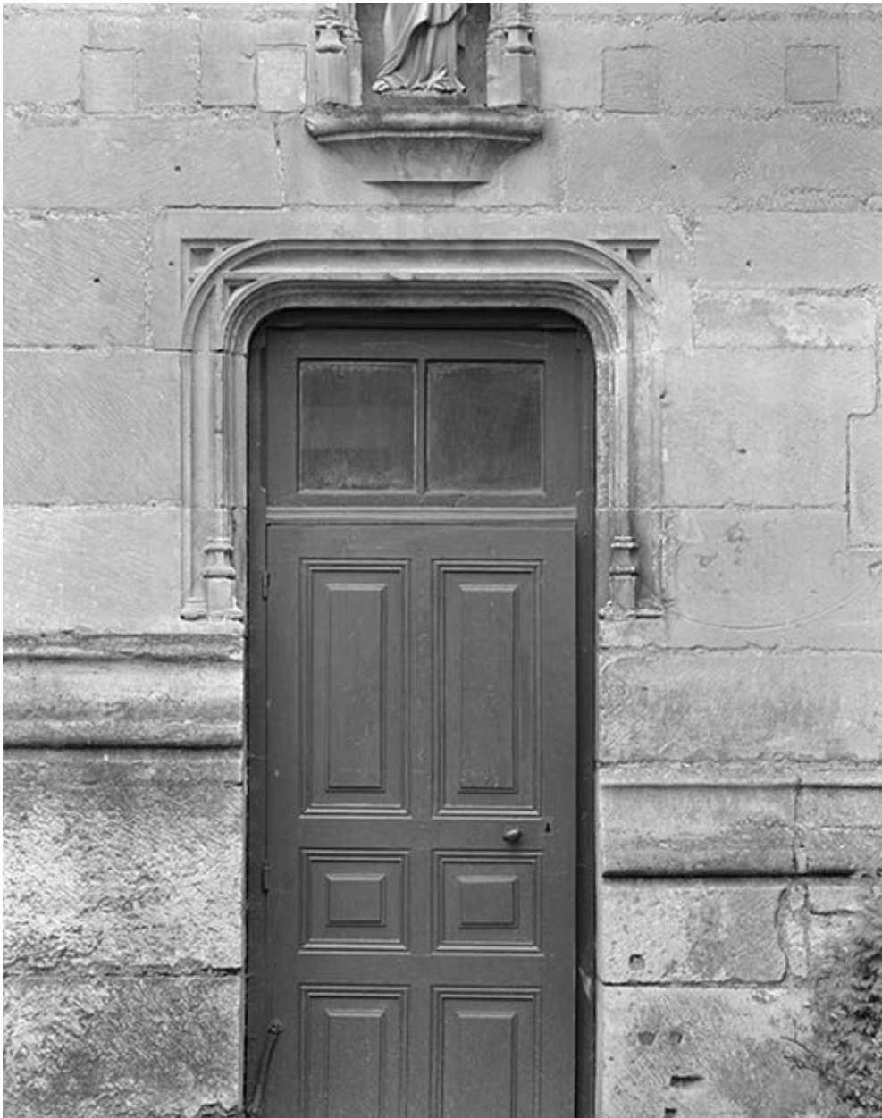
Elévation gauche, 3e travée : porte latérale.
