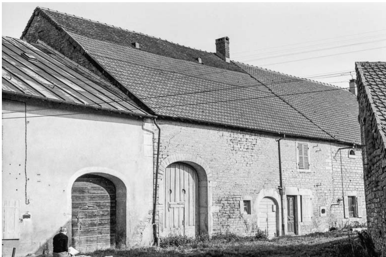
Façade antérieure : vue rapprochée.
