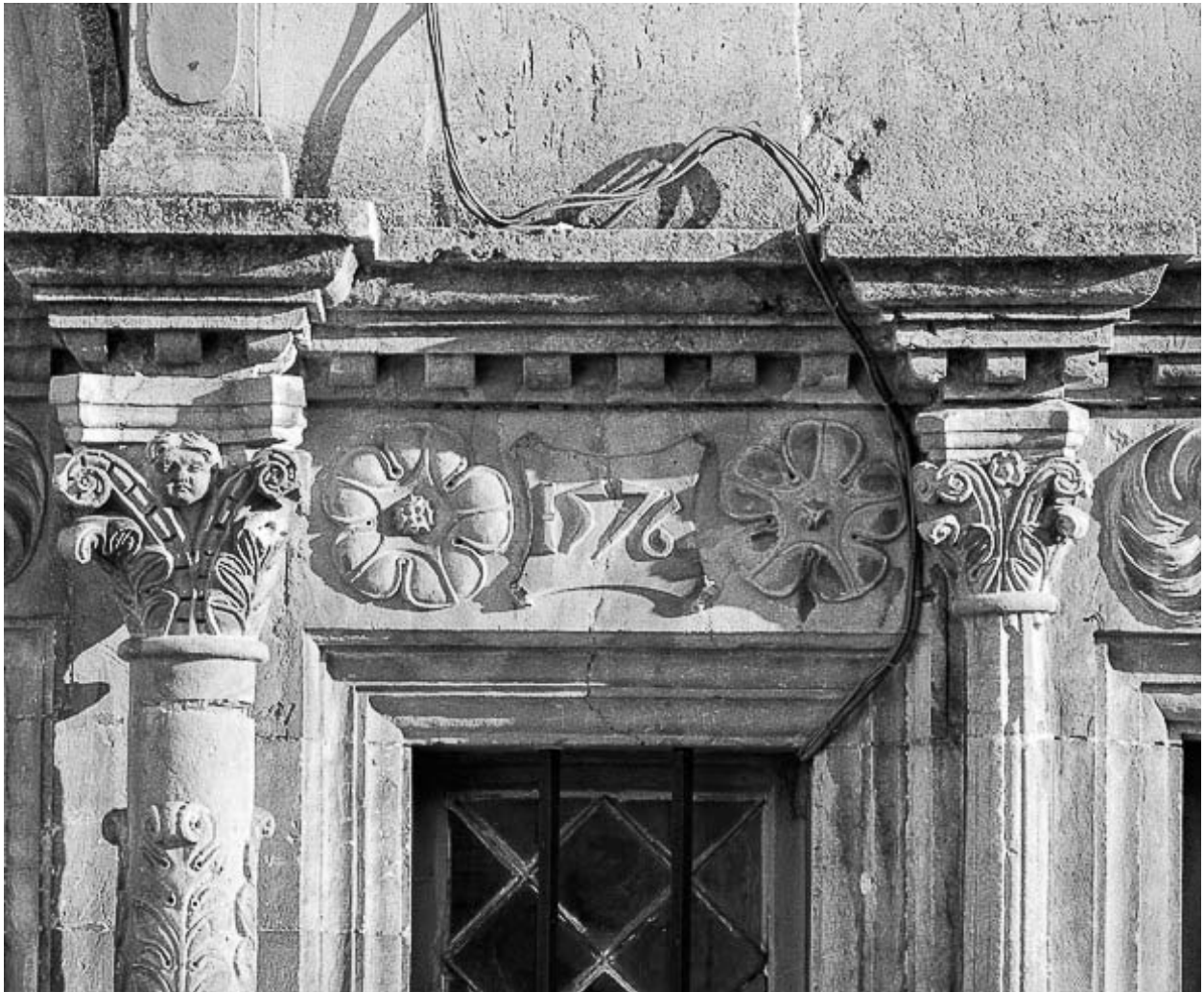
Linteau de fenêtre du rez-de-chaussée.
