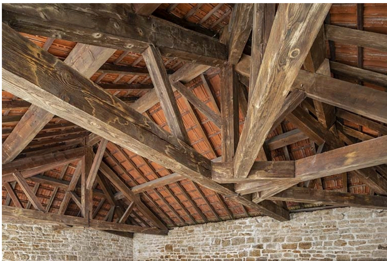
La charpente du lavoir.
