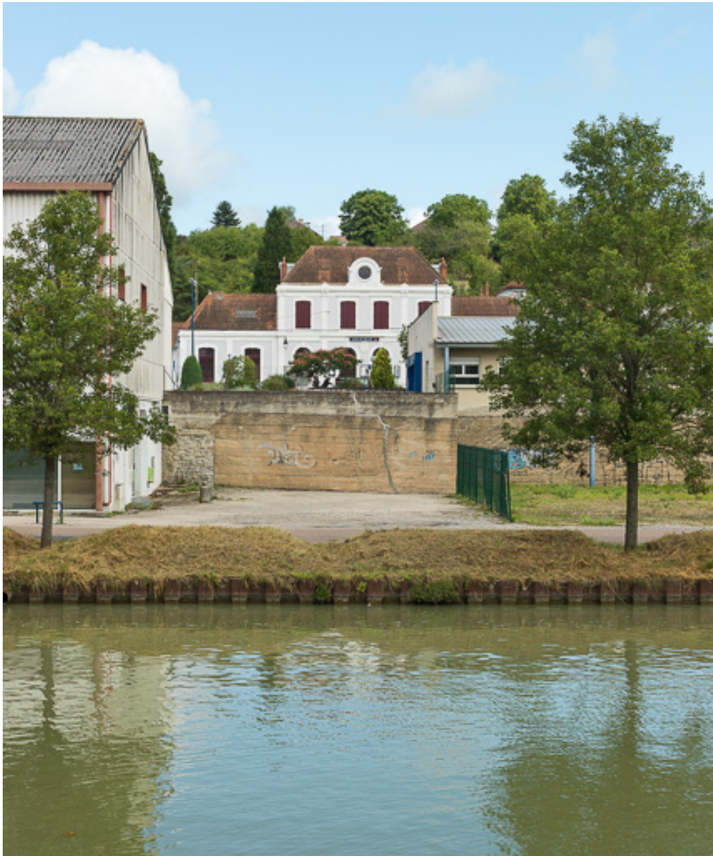
Vue de la gare et du canal.
