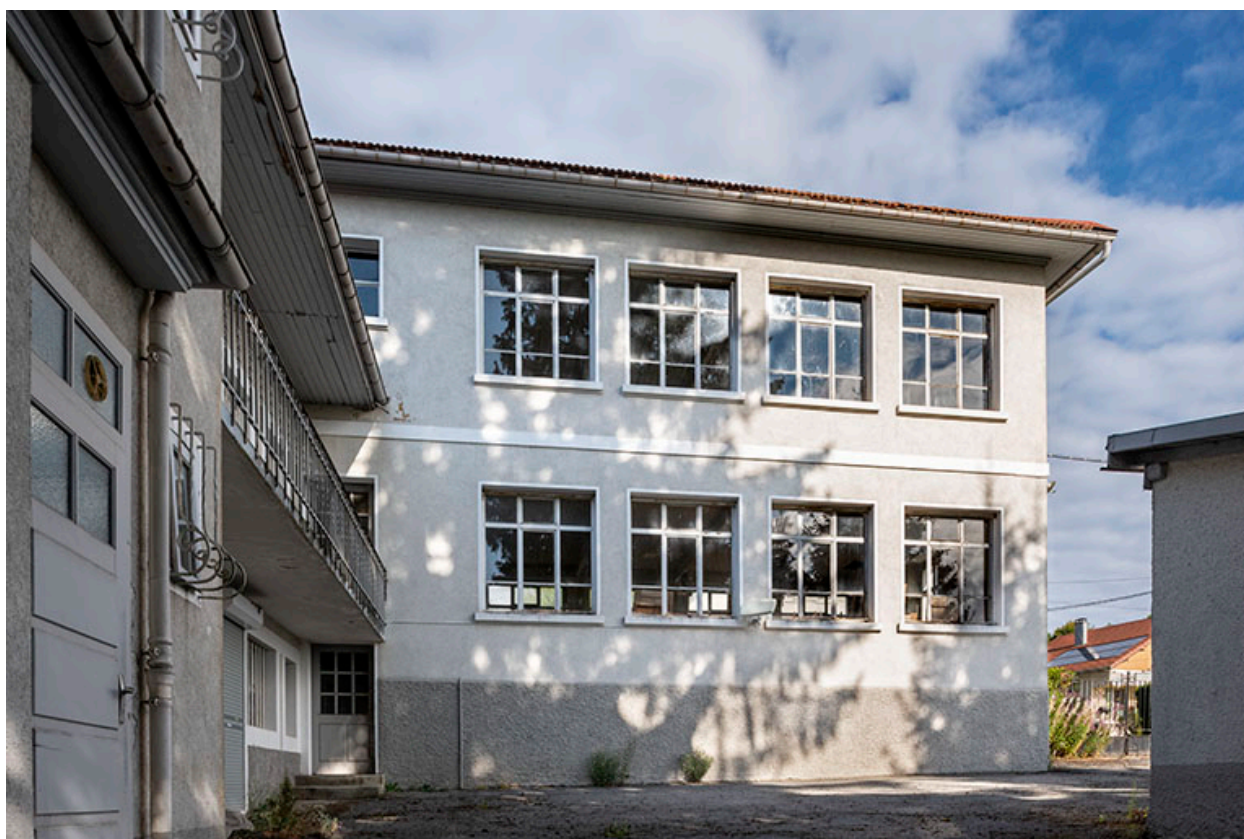
Atelier de 1930 : façade postérieure (est).
