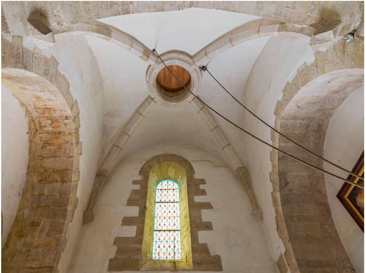
Voûte de la travée sous clocher.
