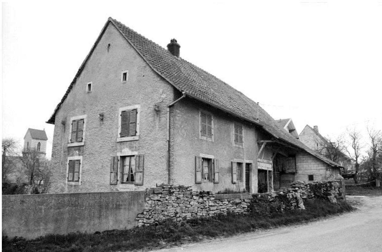
Façades antérieure et latérale gauche.
