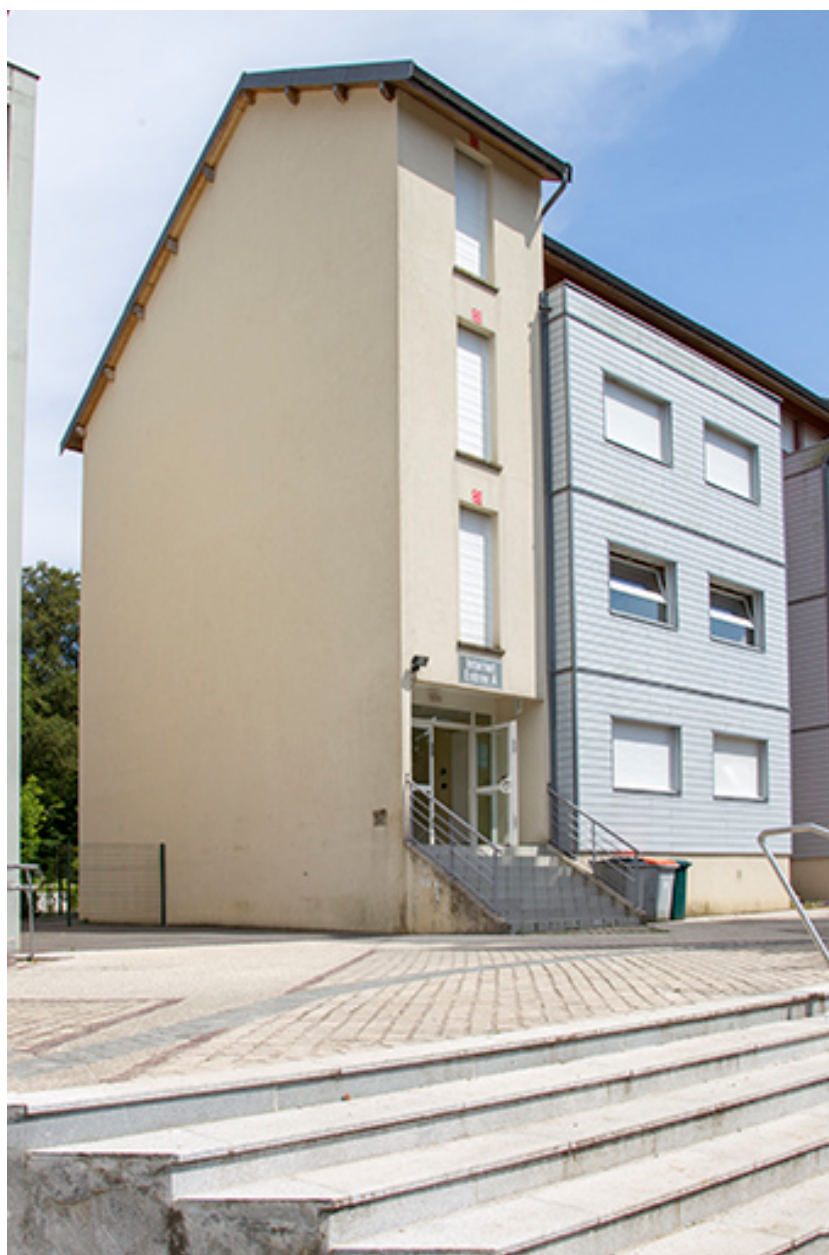
Entrée à l'angle nord-ouest de l'internat.
