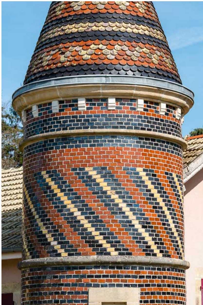
Détail de la tourelle d'angle.
