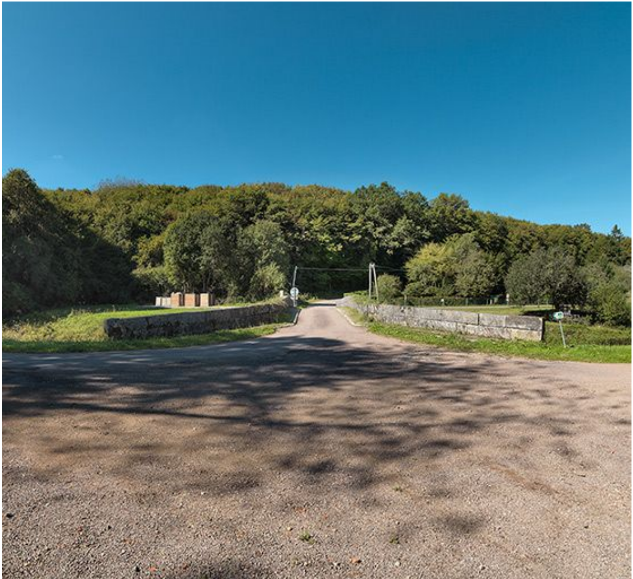
Vue d'ensemble du pont, avec les parapets.
