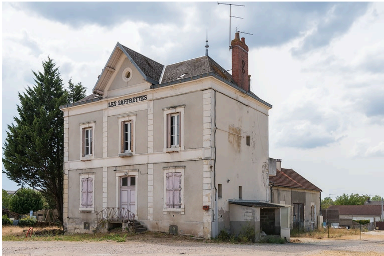
Vue de trois quarts, avec la remise et le magasin à l'arrière.
