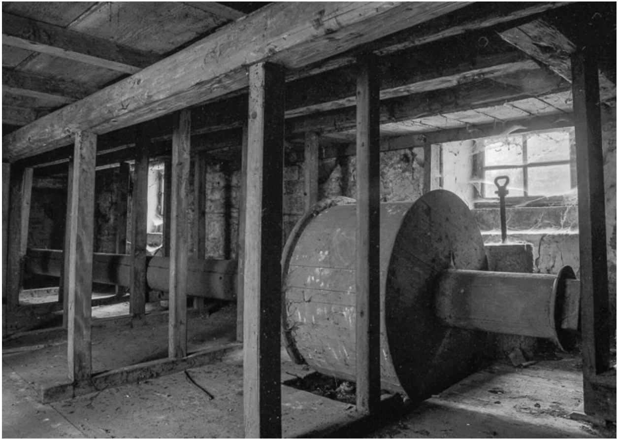
Dessous de scène. Tambour de la machinerie (1987).
