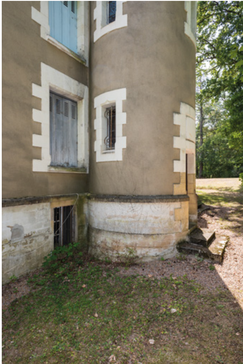
Partie inférieure de la tour d'escalier.
