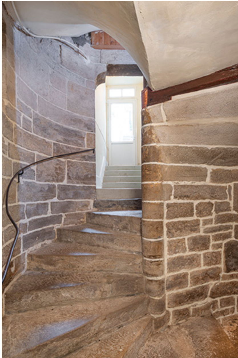
Escalier en vis (premier étage).
