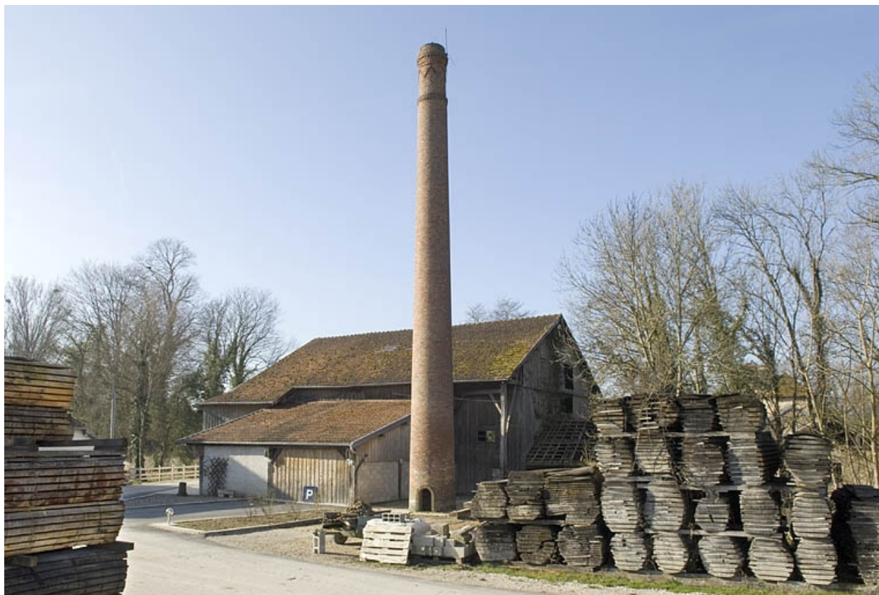
Vue d'ensemble de l'entrée depuis le nord-ouest.
