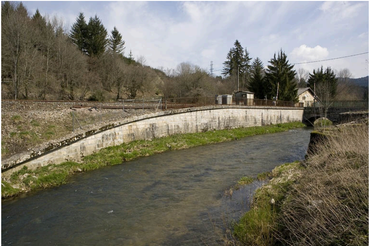
Passage à niveau n° 100 et mur de soutènement, depuis la rive droite de l'Ange à l'ouest.
