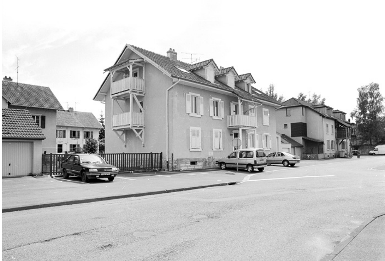
Logements collectifs (1902) rue Kléber.
