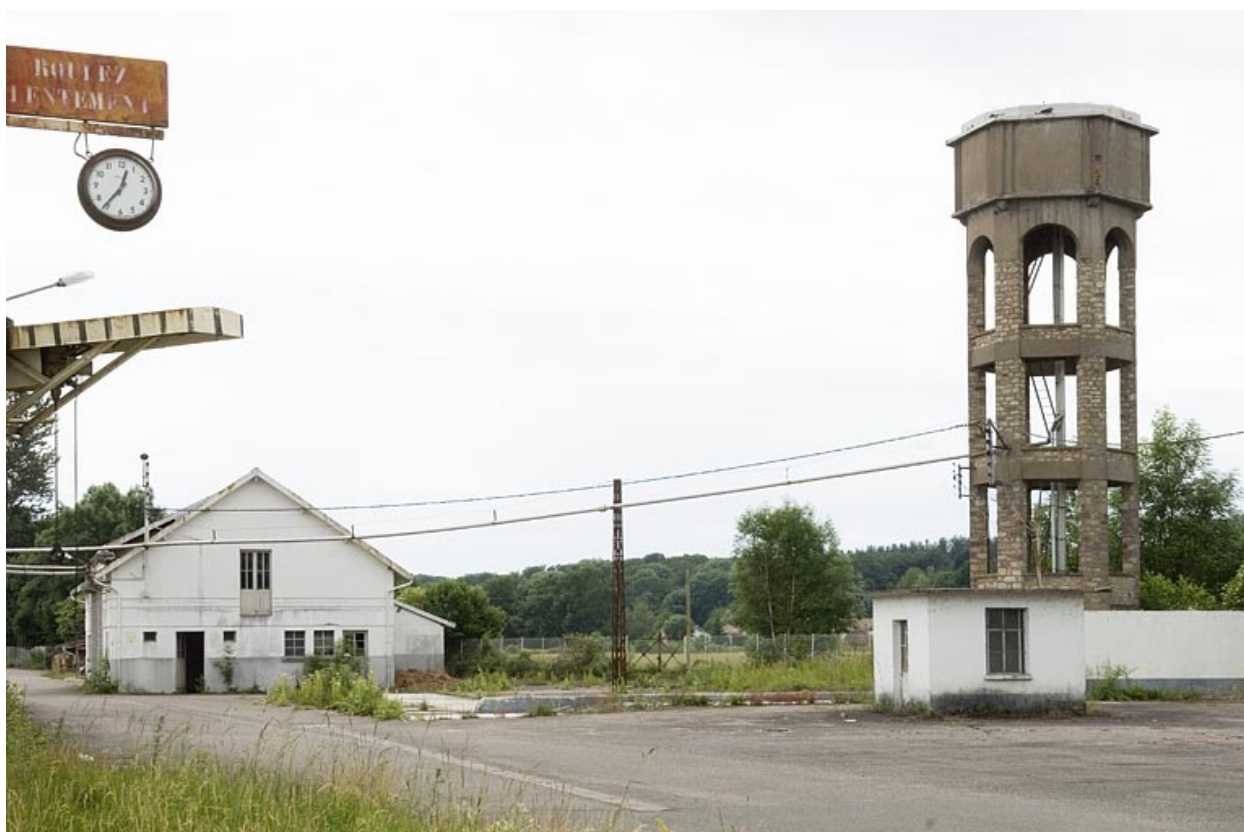
Garage à camions et château d'eau.
