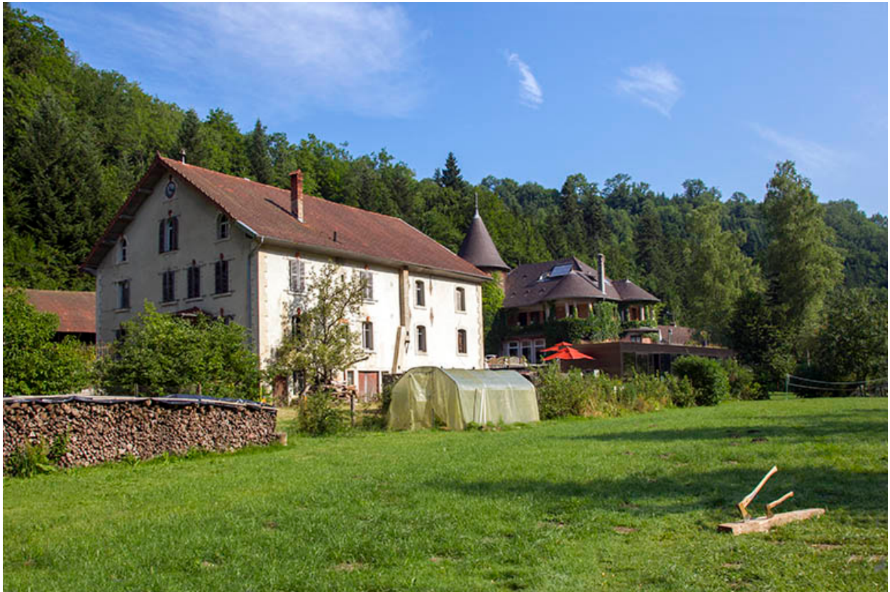
Vue d'ensemble du site, depuis le sud-est.
