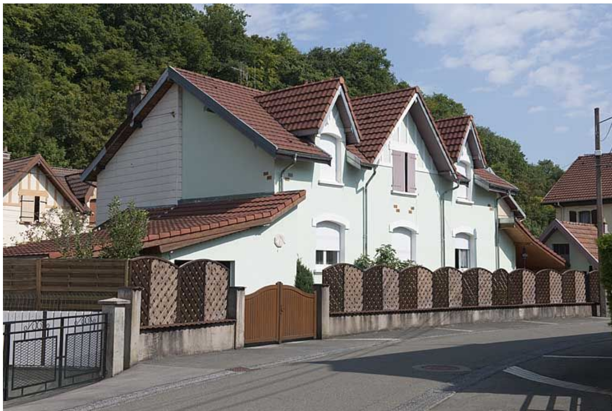
Habitation à 2 logements vue de trois quarts.
