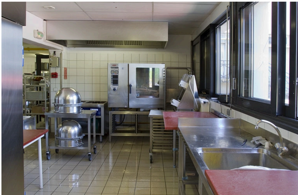
Restauration : la cuisine.
