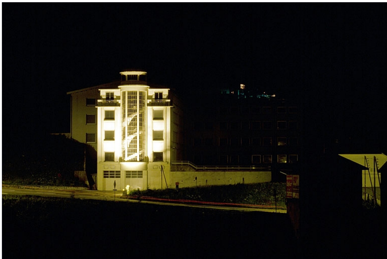
Cage d'escalier demi-hors-oeuvre, de nuit.
