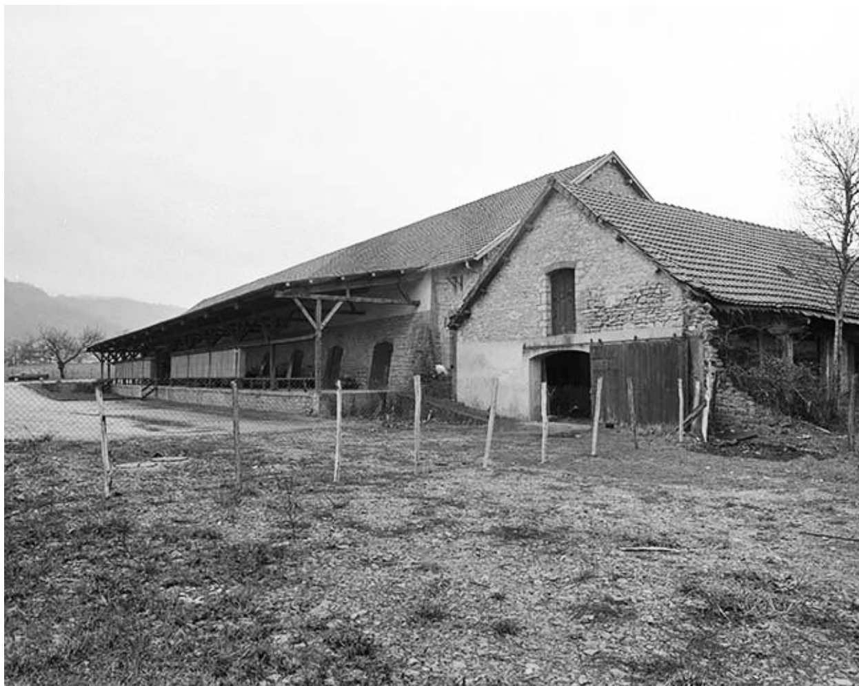
Magasin industriel et atelier de fabrication ruiné.
