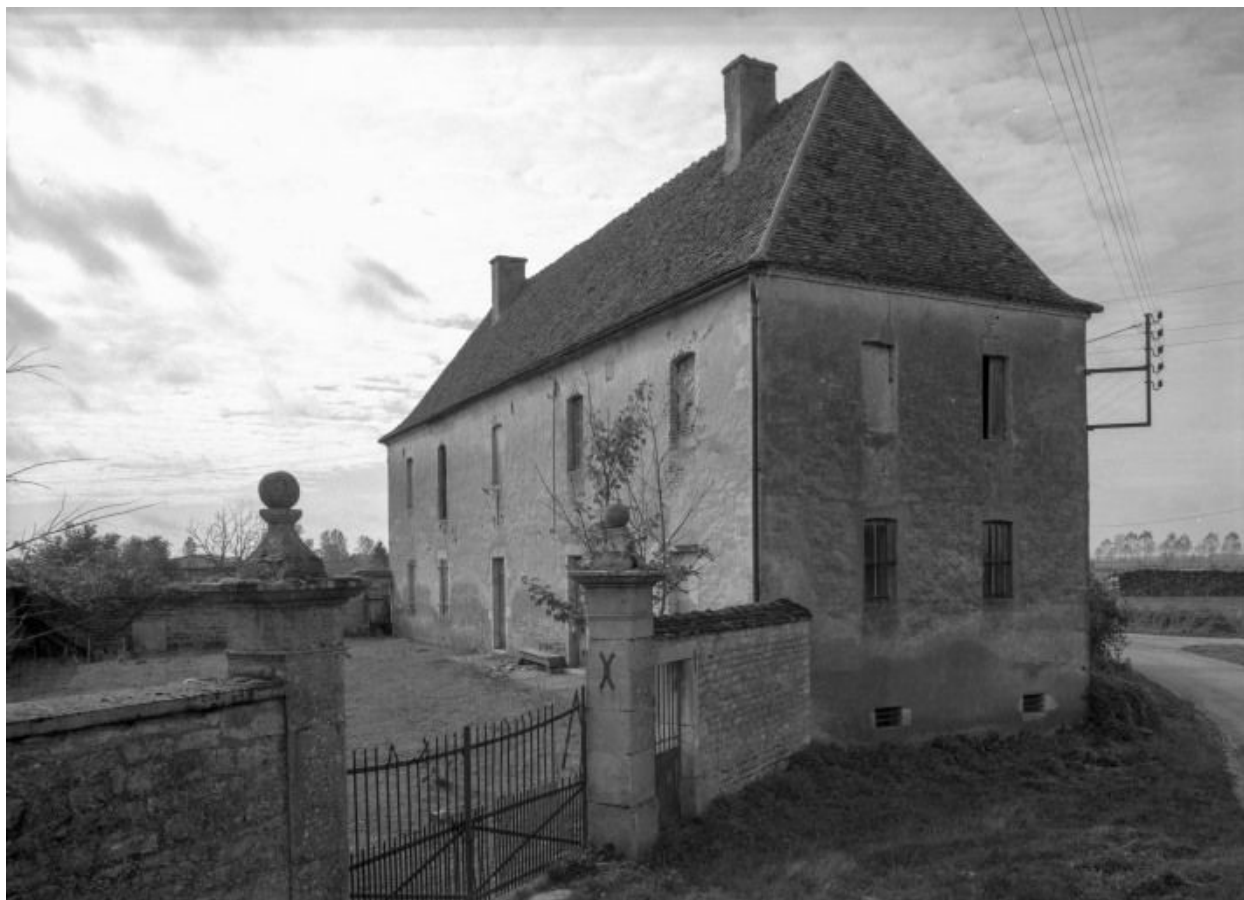
Portail et bâtiment d'habitation.
