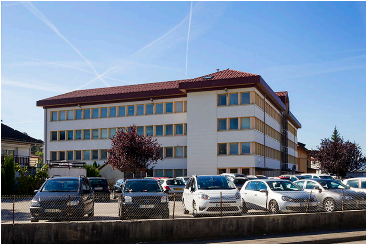
Usine : façade latérale gauche, de trois quarts.
