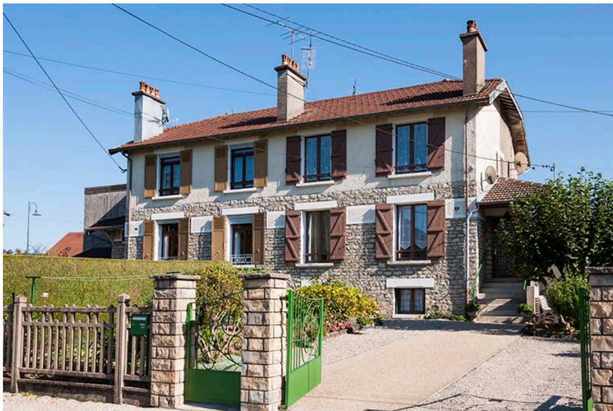
Façade antérieure d'une habitation à quatre logements.
