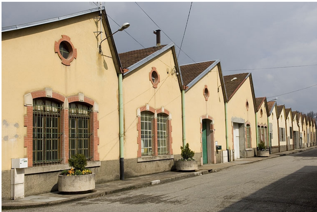
Pignons de sheds.
