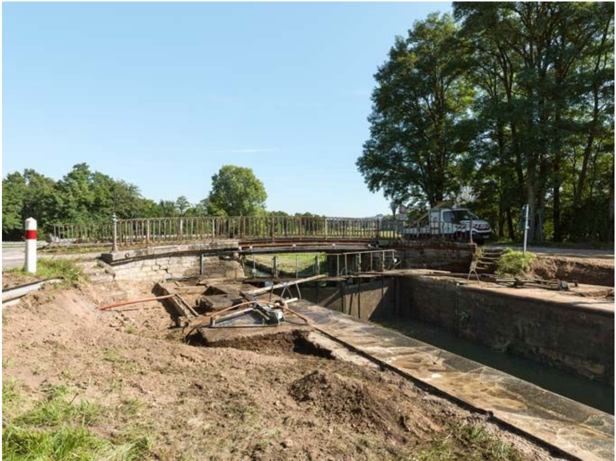
Vue d'ensemble du site d'écluse.
