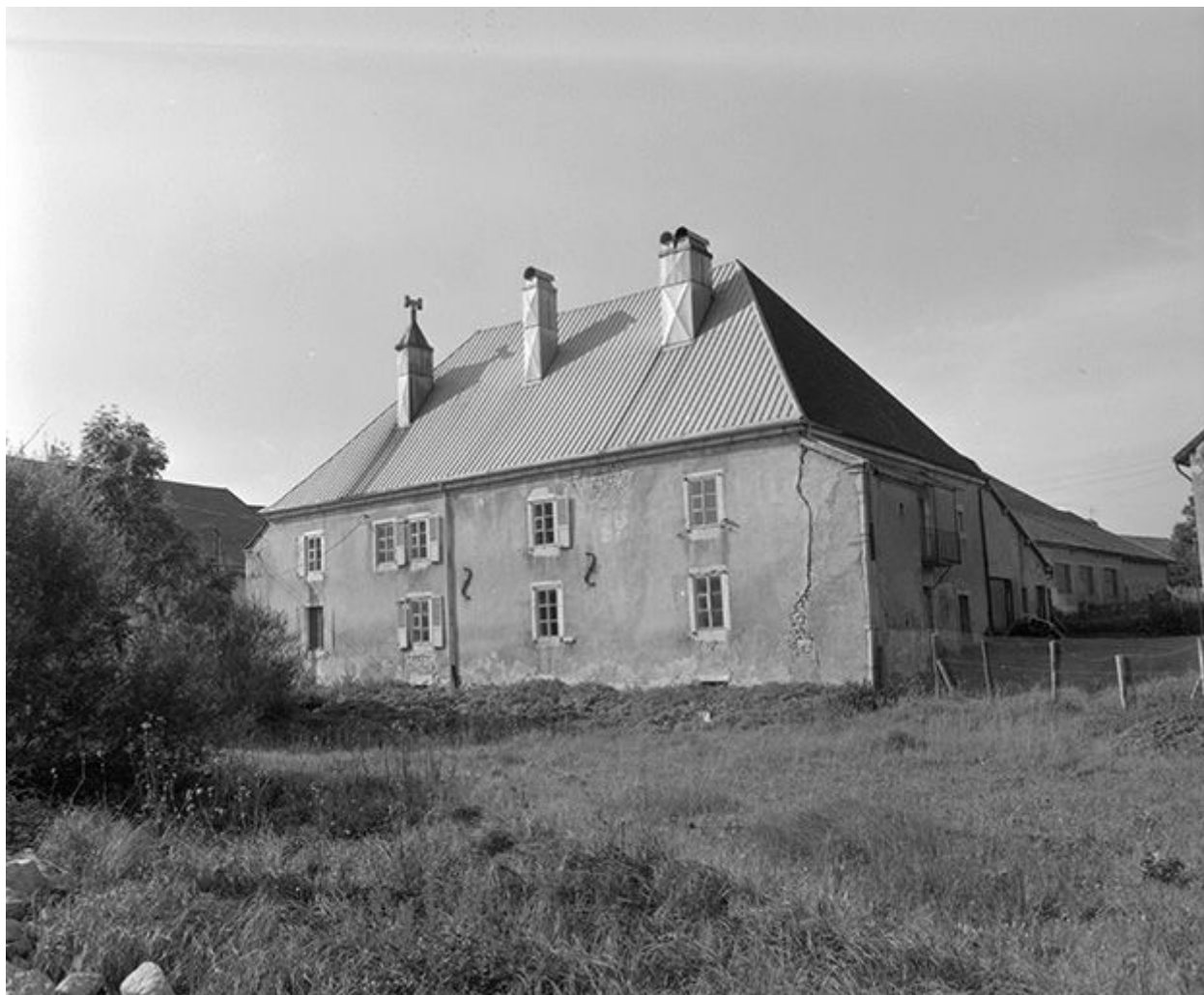
Façade latérale droite.
