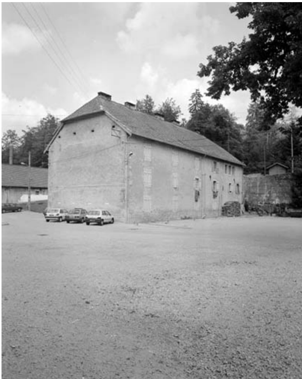
Logement d'ouvriers et ancienne poste depuis la cour.
