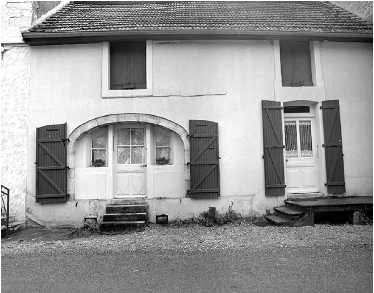
Façade antérieure du logement d'ouvriers.
