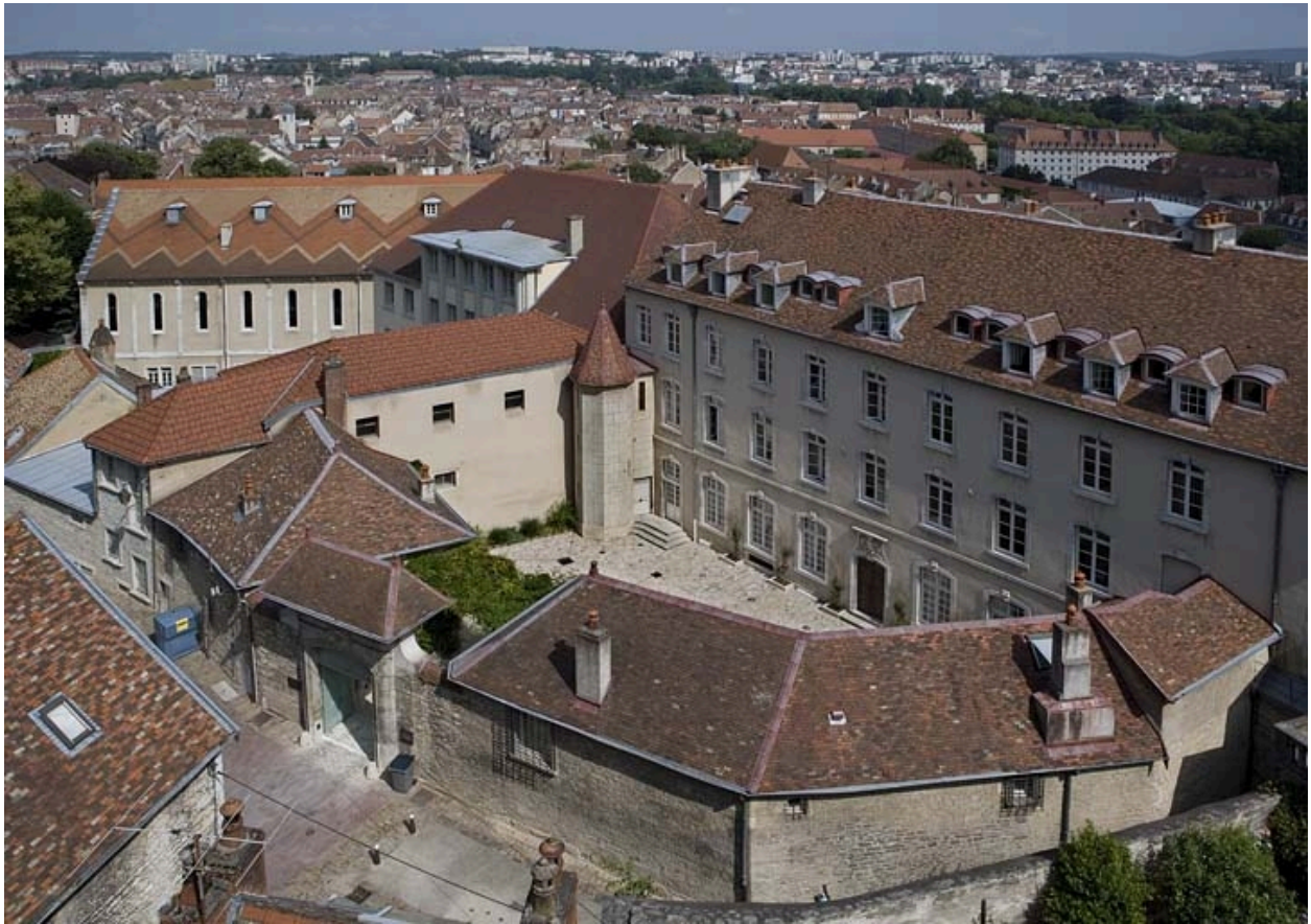
Vue d'ensemble des bâtiments autour de la cour.
