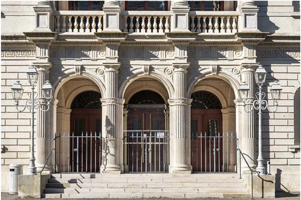
Façade antérieure : baies du rez-de-chaussée.
