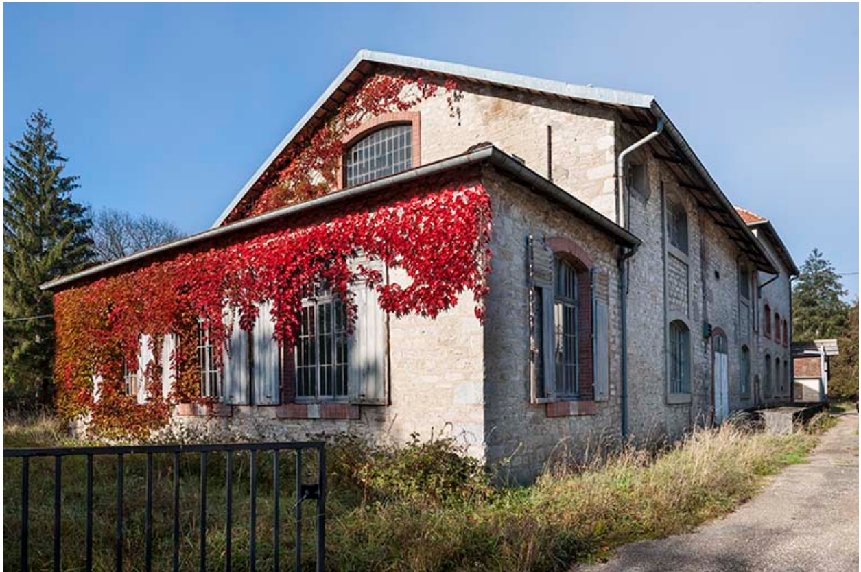
Bâtiment de la distillerie (salles des alambics ?).
