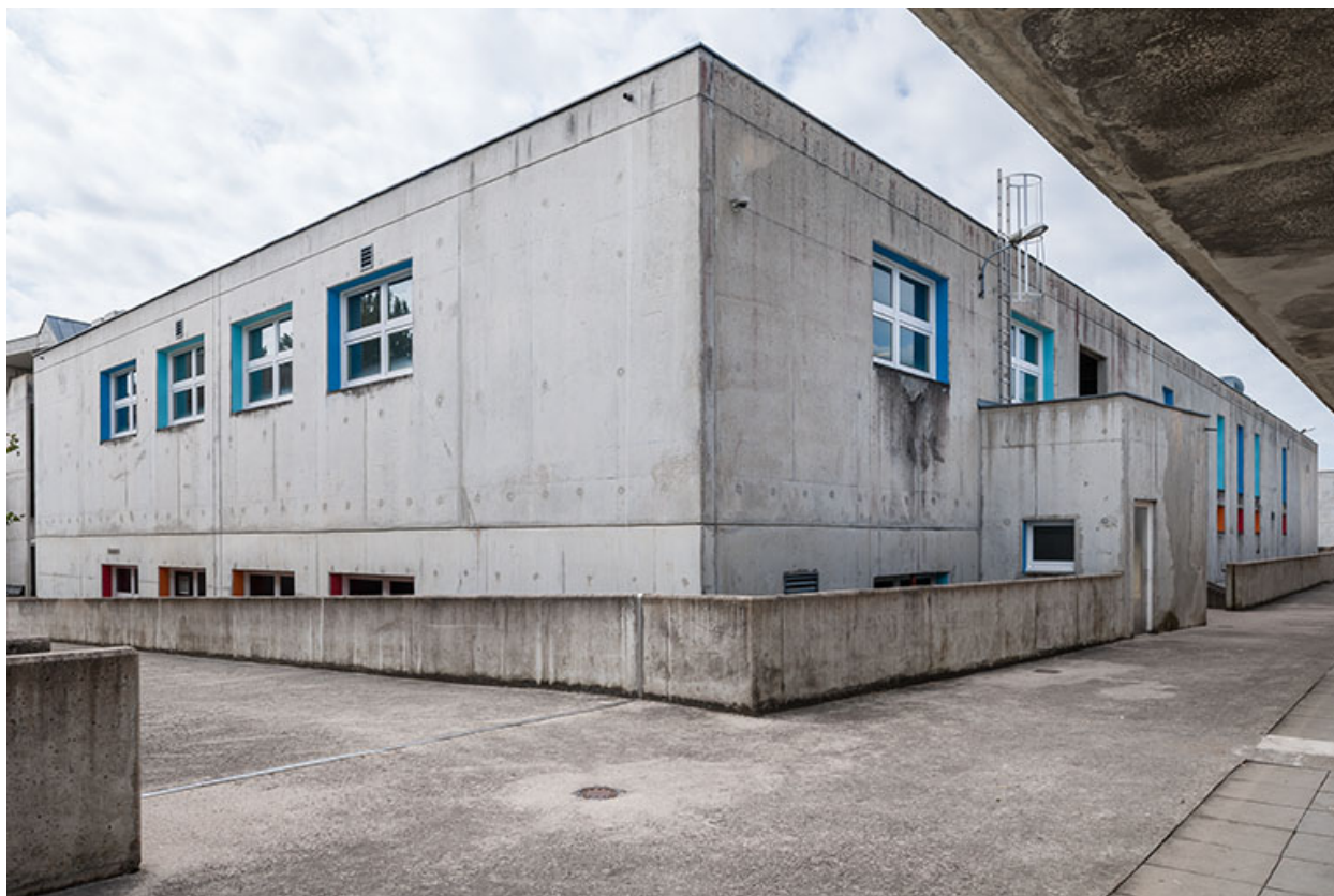
Atelier métal : façade latérale.
