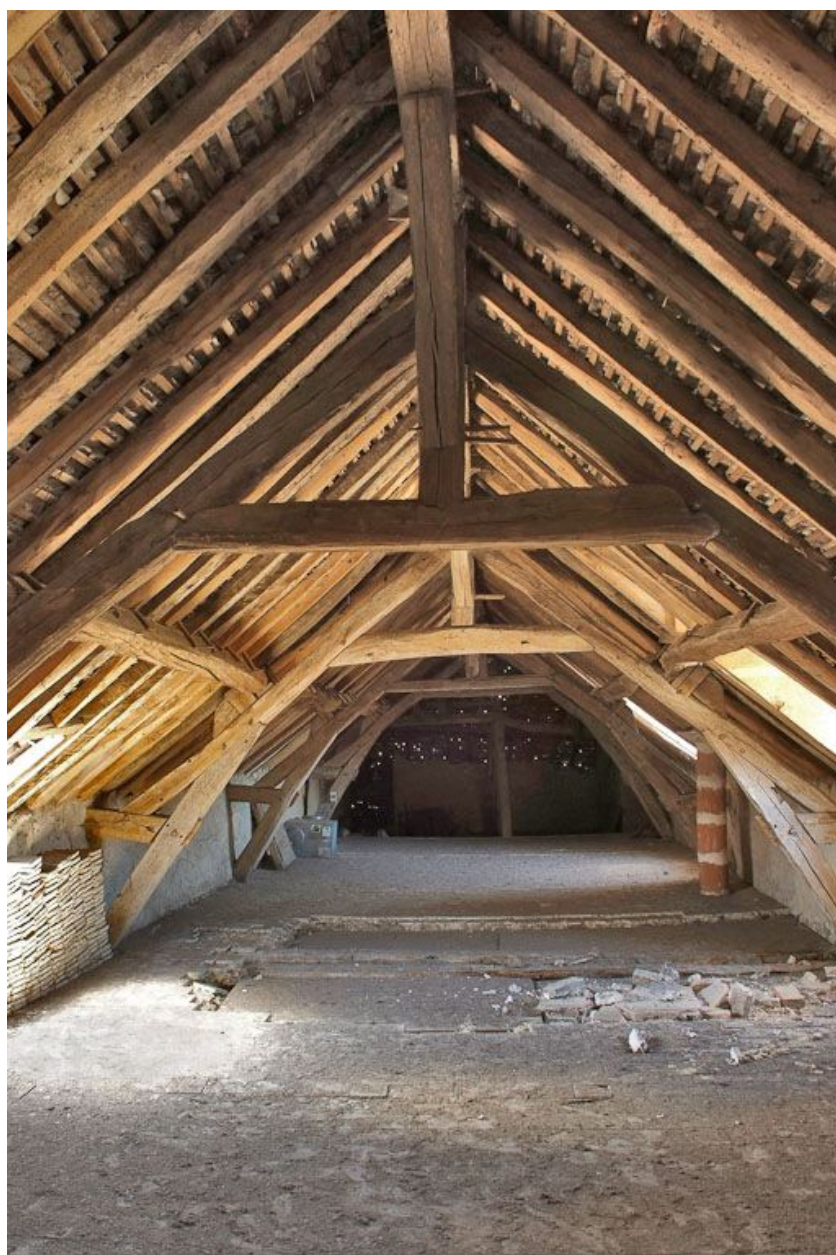
Comble et charpente du bâtiment sud.
