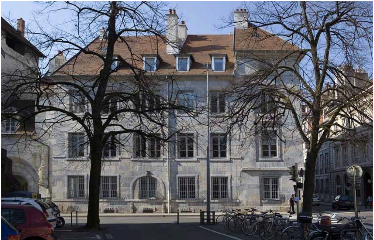
Vue d'ensemble de la façade latérale gauche depuis la promenade Granvelle.
