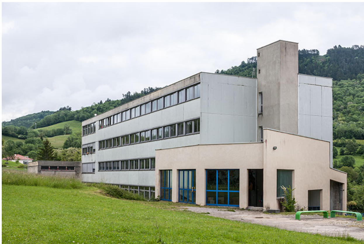
Angle nord-ouest de l'internat de filles.
