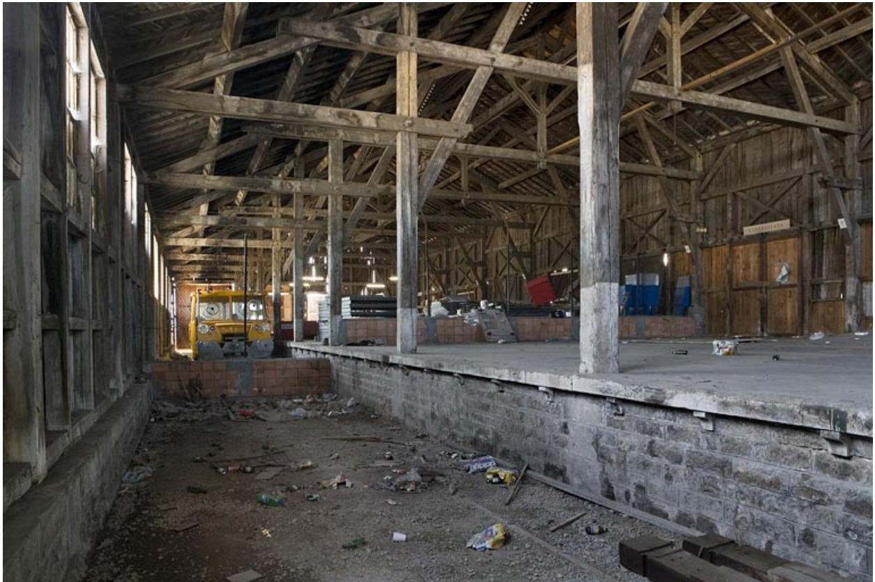
Entrepôt : intérieur, depuis l'angle nord-ouest.
