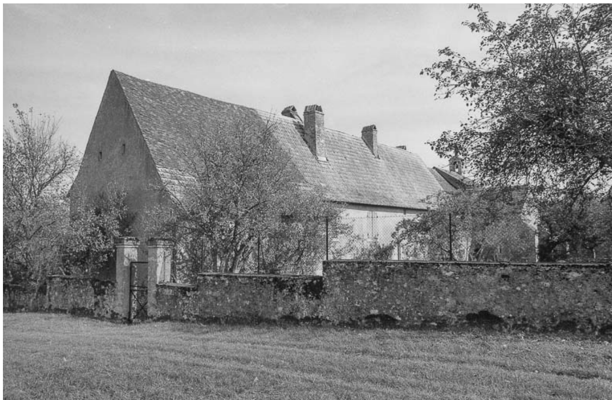
Bâtiment annexe, façade postérieure sur jardin.
